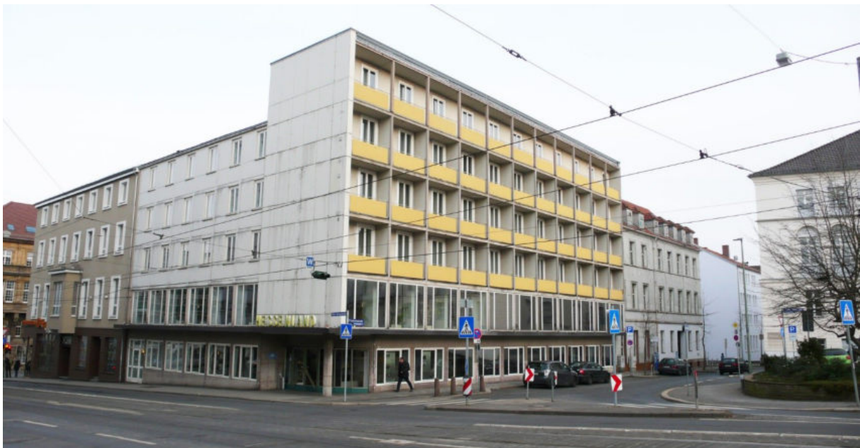
Abb. 10: Ansicht im Januar 2019: Königsstraße 4, Königsstraße 2 (Hotel Hessenland), Friedrichsstraße 25. Die Gesamtheit des Hotels einschließlich des dreiachsigens Teils in der Friedrichsstraße geht auf den bekannten Kasseler Architekten Paul Bode zurück, Bauzeit 1951–53.
