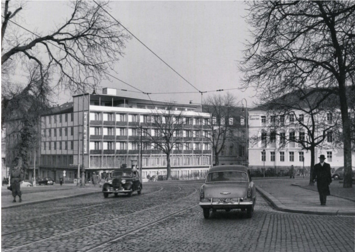
Abb. 20: Ansicht des neuen Hotels Hessenland 1954, rechts Brüder-Grimm-Platz 4. Aus: Frank-Roland Klaube: Kassel lebt. Neubeginn aus Trümmern, Gudensberg-Gleichen 1990, S. 35 (Originalvorlage: Stadtarchiv Kassel, 0.007.478, Aufnahme aus dem Januar 1954).
