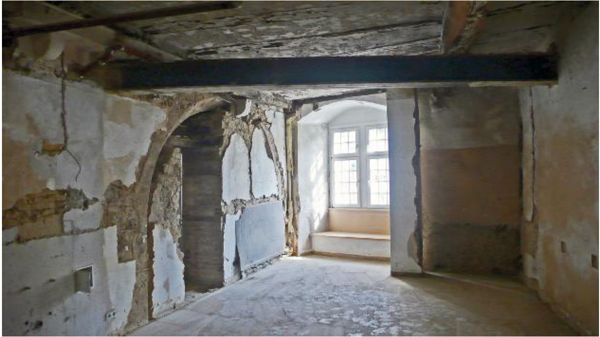
Abb. 8: Die Küche der ehem. Verwalterwohnung im EG des Westflügels; links der um 1567 vermauerte Bogen. Der Raum ist (mit Ausnahme der später geschlossenen Kellertreppe) in seinem Volumen seit 1567 unverändert geblieben.
