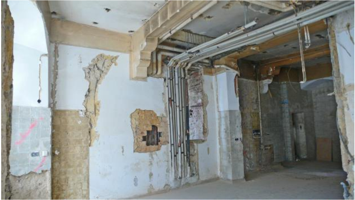
Abb. 10: Die beiden Räume der Hofschule im Bereich der 1567 gebrochenen Hofdurchfahrt: mutmaßlich links der kleine Saal, rechts die Küche der Hofschule; in die Trennmur wurde im 20. Jh. eine große Öffnung gebrochen. Man erkennt die beiden Unterzüge von 1598/99, die auch im Grundriss von 1844 wiedergegeben sind (Abb. 7) und die zur Verminderung ihrer Spannweite (statisch relevant) auf großen Konsolen ruhen. Die Konsole im kleinen Saal ist in den damals schon längst vermauerten Bogen eingebaut, und die Trennmur zur Küche sitzt wesentlich weiter südlich als in der Zeit des Klosters die Fachwerkwand zum Kreuzgang (vgl. Abb. 3 und 7).
